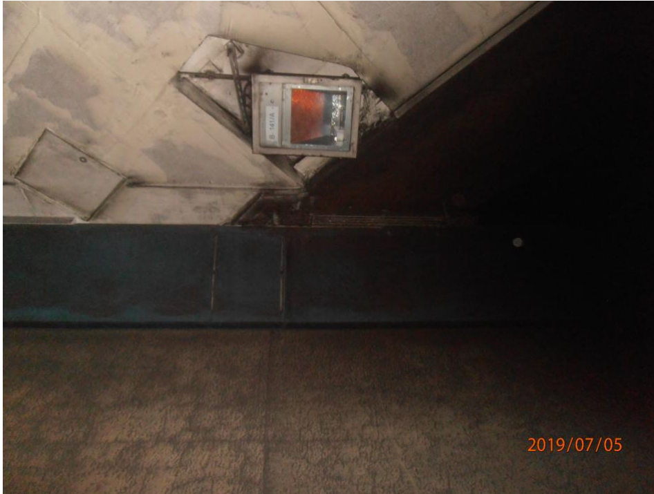
Abbildung 14 Kabelkanal von unten
