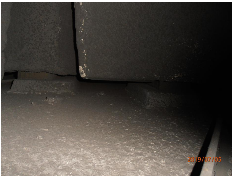
Abbildung 12 Bsp. einer Lagerfuge auf der Mittelwand
